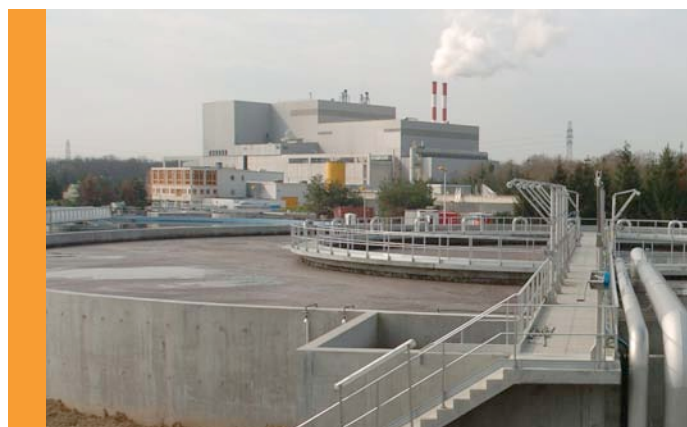
L'incinérateur de l'agglomération mulhousienne : une des principales filières alternatives au recyclage agricole des boues urbaines du département.
