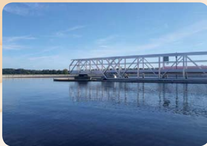
La qualité des boues dépend directement de la qualité des eaux usées qui arrivent à la station d'épuration.
