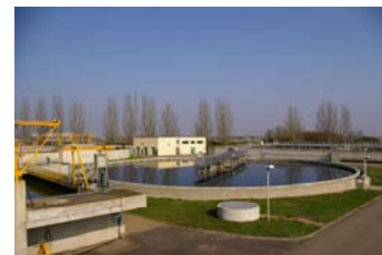
La station d'épuration de Colmar et Environs, sous la responsabilité du SITEUCE, est exploitée par le Groupement Colmarienne des Eaux - Suez
